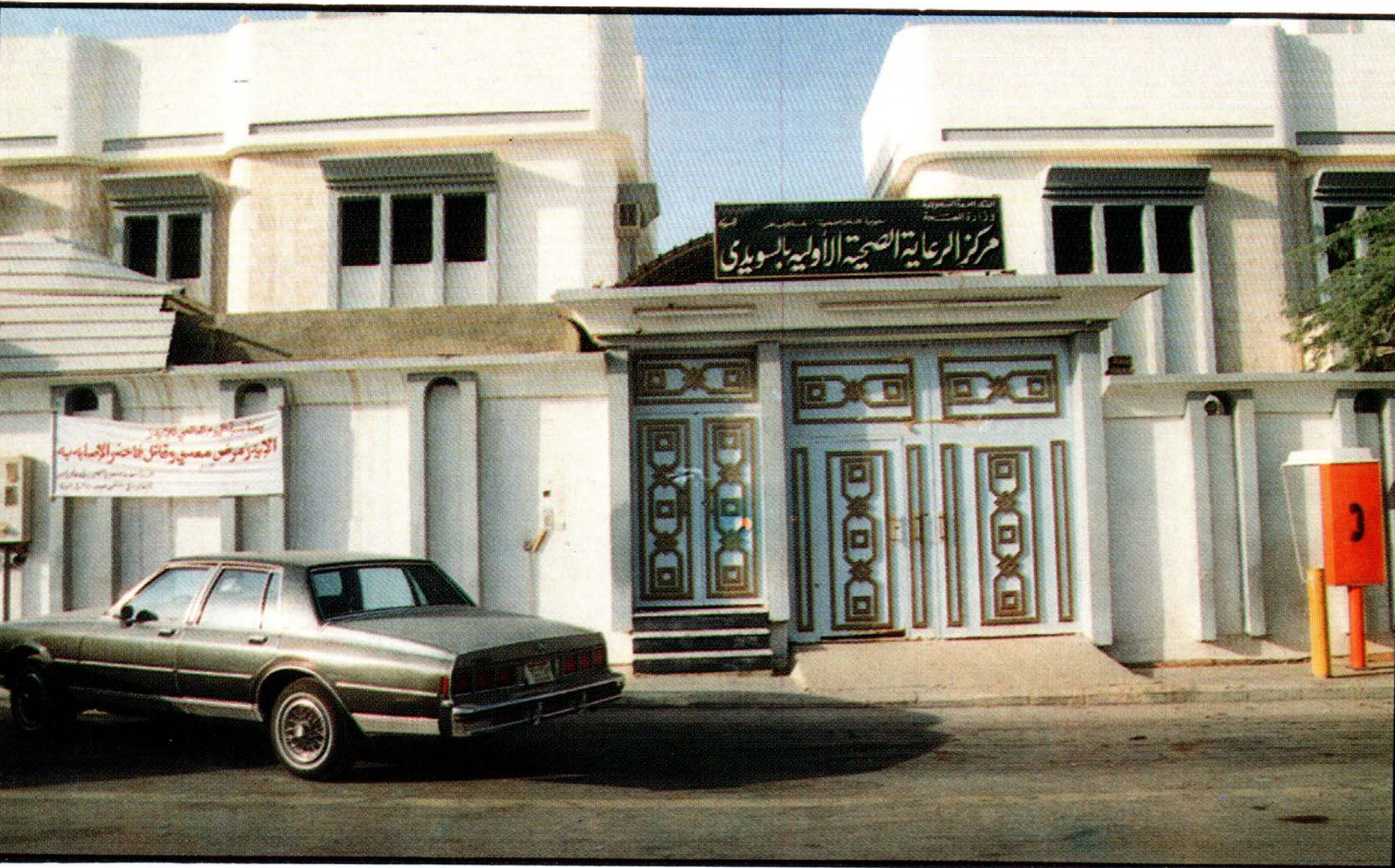
● استعمال حكومي (مركز رعاية أولية) في مبنى سكني.
